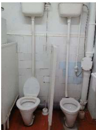
Фото №12 Туалетная комната
